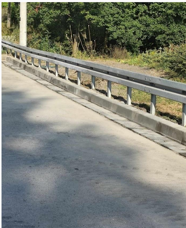
Fot. Odwodnienie dojazdu przy moście w miejscowości Januszno (baza własna)
