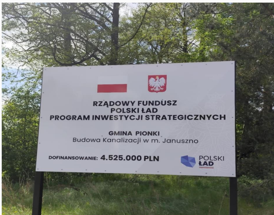
Fot. Budowa kanalizacji w m. Januszno (baza własna)
