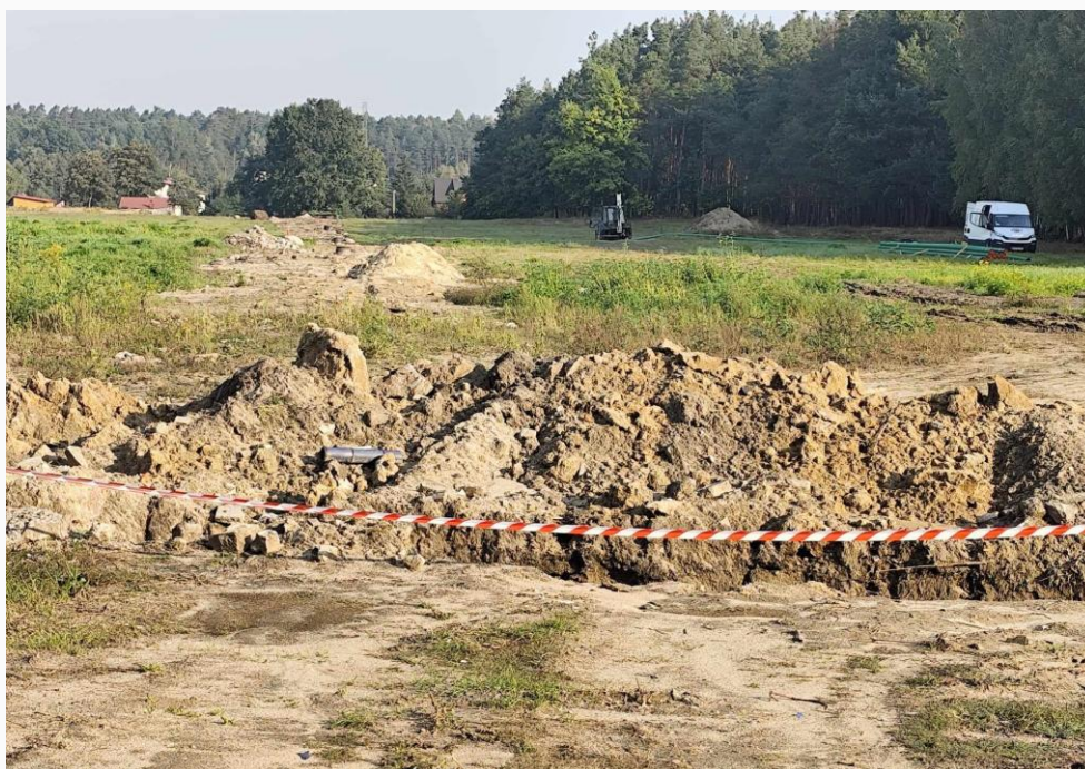
Fot. Prace przy rozbudowie sieci kanalizacyjnej w m. Kamyk (baza własna)
