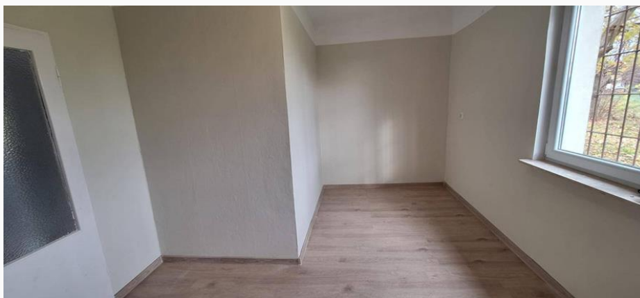
Fot. Remont lokalu mieszkalnego w m. Laski (baza własna)
