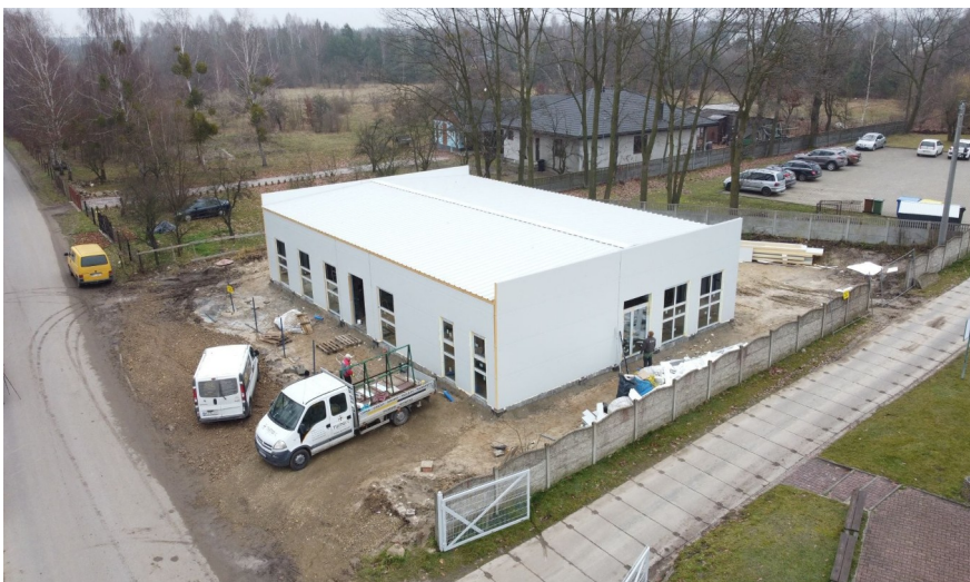
Prace przy budowie żłobka – fot. Urząd Gminy Pionki
