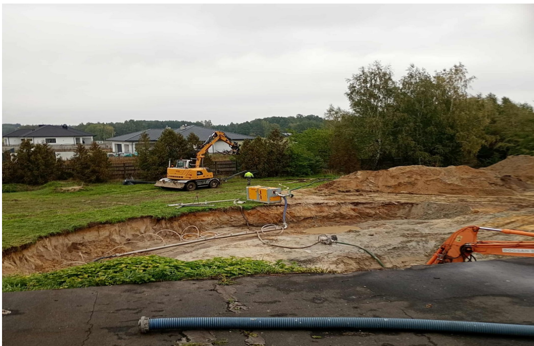
Rozpoczęcie prac rozbudowa i przebudowa oczyszczalni ścieków – fot. Urząd Gminy Pionki
