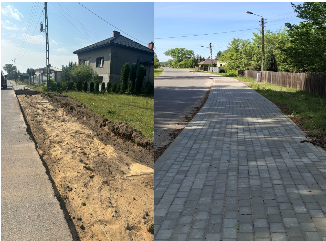
Budowa chodnika w miejscowości Sucha – fot. Urząd Gminy Pionki
