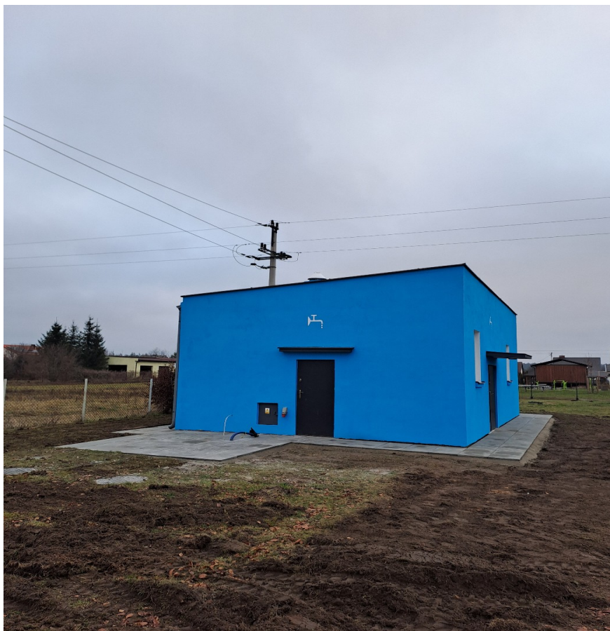
Stacja Uzdatniania Wody w Augustowie po remoncie- fot. Urząd Gminy Pionki
