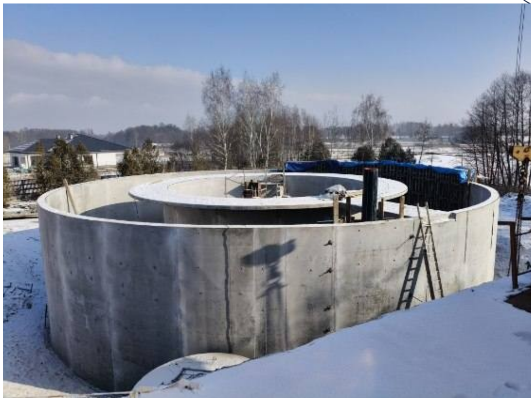
Prace przy rozbudowie i przebudowie oczyszczalni ścieków – fot. Urząd Gminy Pionki
