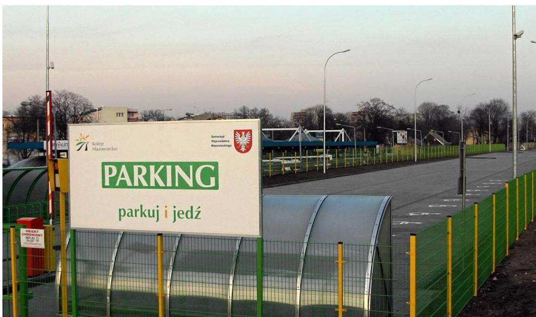
Rys. 4.4 Parking P+R Radom Główny.
