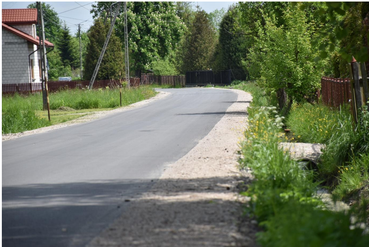
Nawierzchnia drogi gminnej w miejscowości Wincentów, fot. Urząd Gminy Pionki
