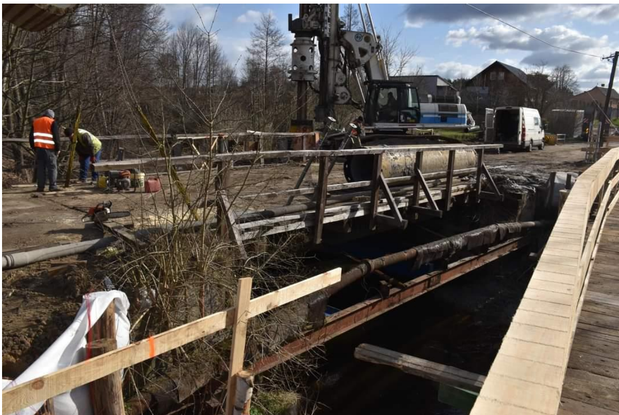
Rozbiórka starego mostu w Janusznie, fot. Urząd Gminy Pionki
