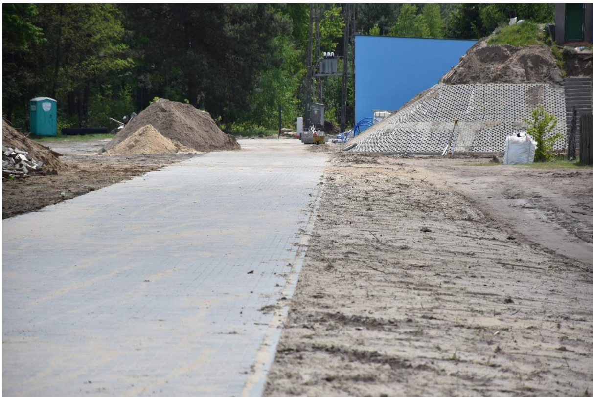
Modernizacja SUW w Mireniu – w trakcie realizacji, fot. Urząd Gminy Pionki
